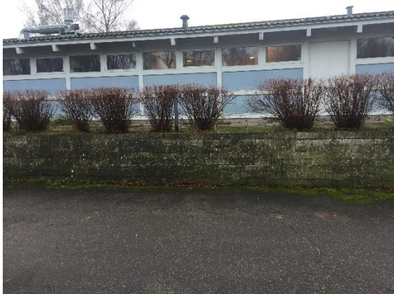
Støttemuren som deler delområde A
